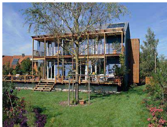
veranda als overgang naar buiten:
